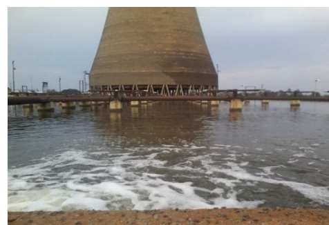
Effluent Treatment Ponds
